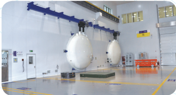
真空热试验大厅
